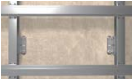
Metal façade substructures
