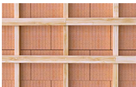
Telai e sottostrutture in legno.
