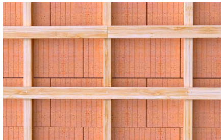
Sottostrutture in legno.
